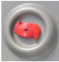
Für Notfälle befindet sich oben an den Türen ein Entlüftungsventil. Lassen Sie die Luft ab, indem Sie das Ventil im Uhrzeigersinn drehen und nach innen drücken, um die Tür zu öffnen.
